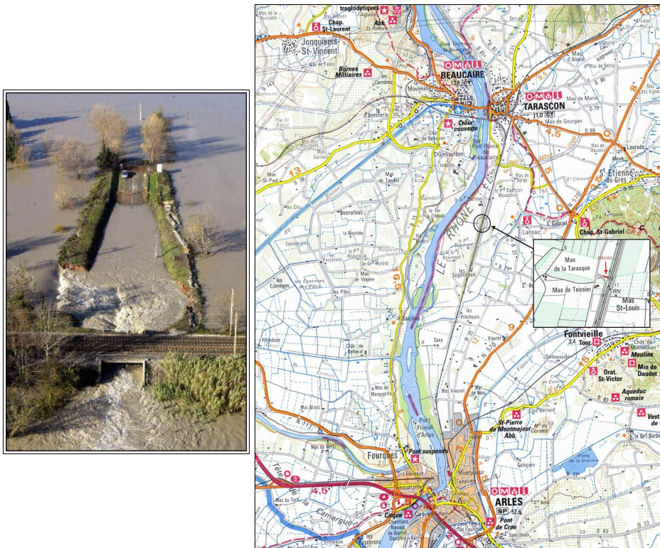
Figure 1: Le cours du Rhône entre Tarascon et Arles. Le remblai ferroviaire est indiqué, avec une loupe sur une des trémies ayant rompu le 3 décembre 2003 (à gauche)
