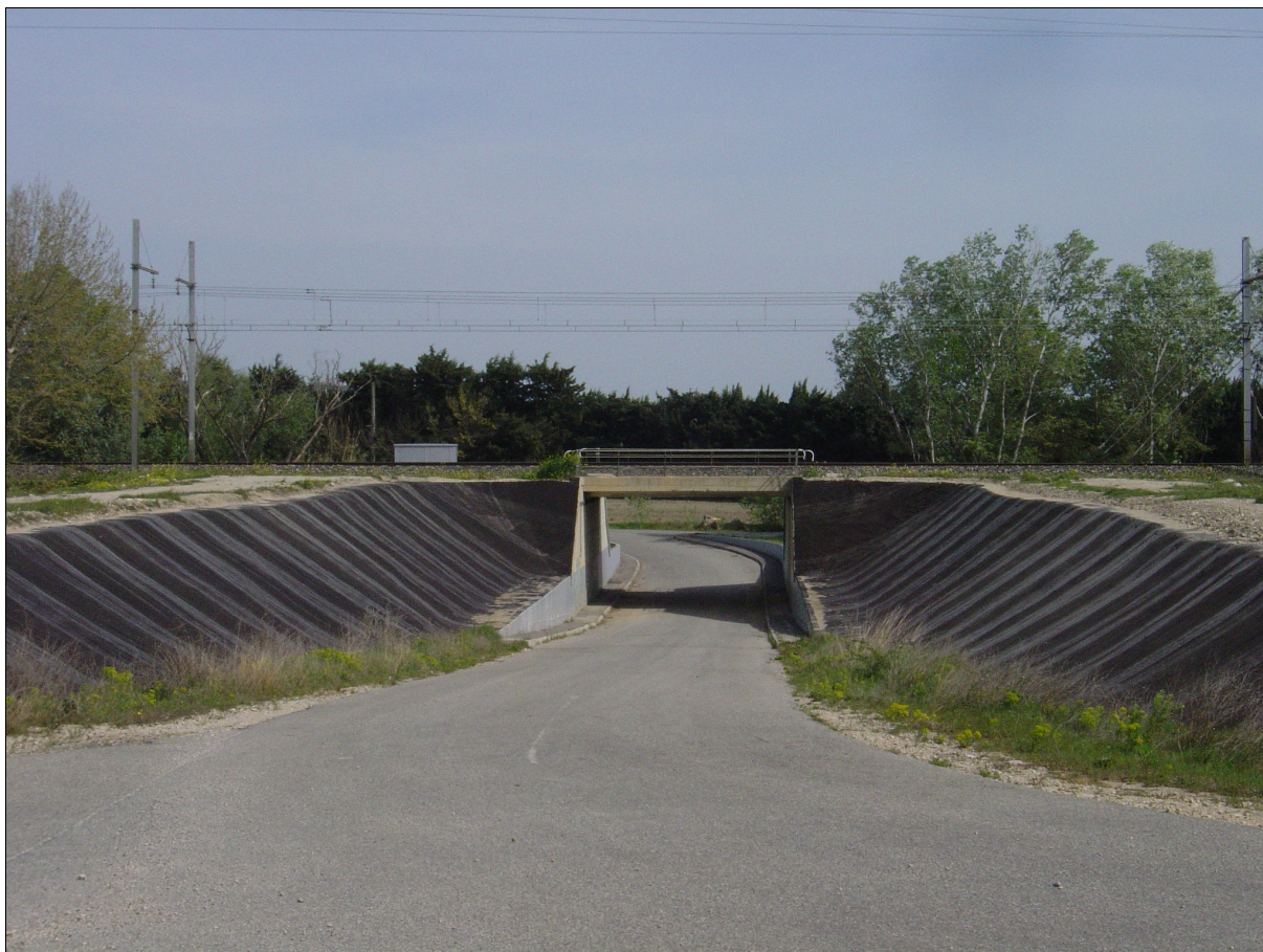
Figure 6: La trémie des ségonnaux reconstruite après la crue de 2003
