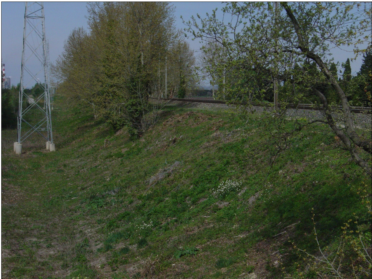
Figure 5: Le remblai ferroviaire à la hauteur de la trémie des ségonnaux
