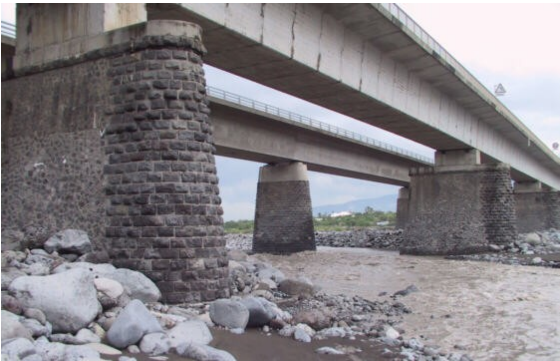
Photo 16 : Pile P7 aval dans le chenal entre P7 et P8 amont
