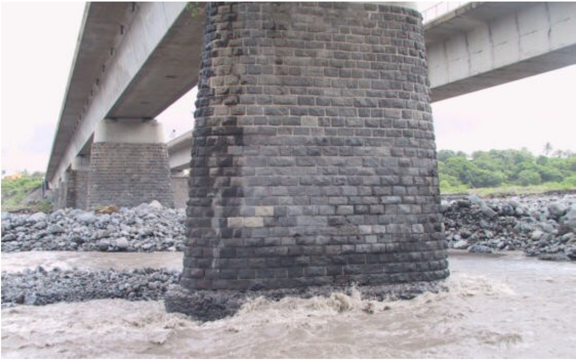
Photo 15 : Pile P7 aval à la fin de DIWA
