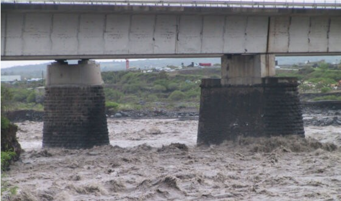
Photo 17 : Piles P8 amont et aval pendant DIWA
