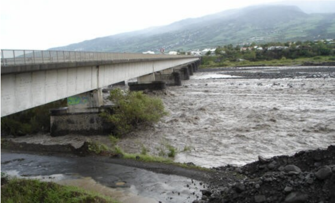
Photo 5 : Vue du tablier amont pendant la crue
