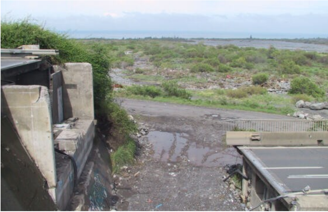
Photo 9 : Avancée du tablier à la culée C11
