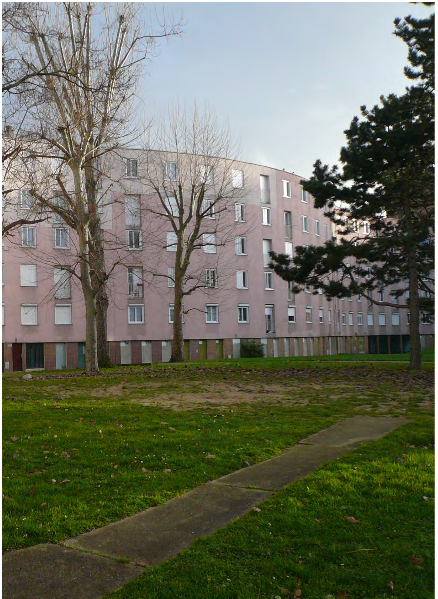
en marches d'escalier, sur les façades.
