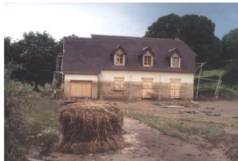
Maison en construction 41 , à l'amont, dans la rue Poncy. On distingue bien la laisse de crue.
