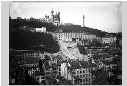
Écroulement de la colline de Fourvière à Lyon le 13 novembre 1930 70 . (19 pompiers soit 20% des effectifs des pompiers de la ville ont trouvé la mort).
