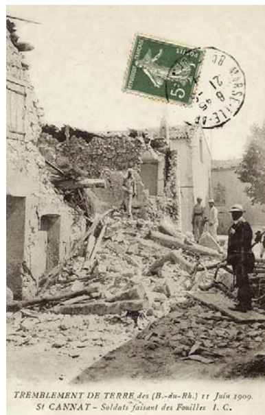
Séisme de Lambesc (Bouches-du-Rhône), le 11 juin 1909.
