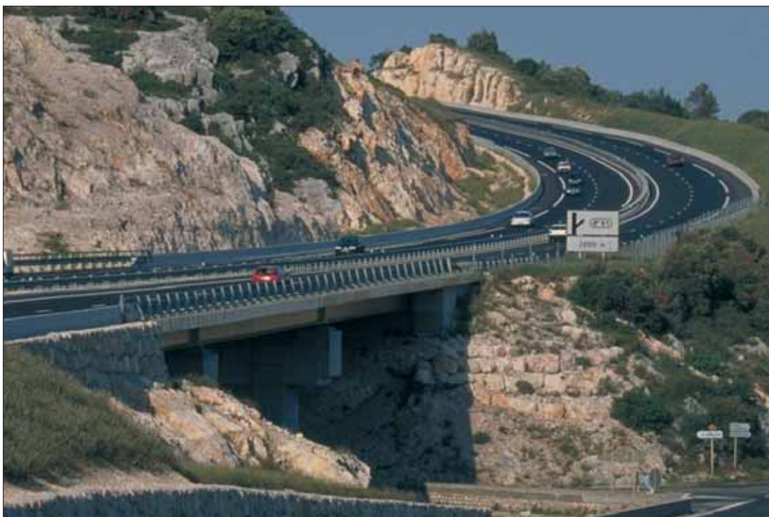
RN 109 - Déviation de Saint-Paul et Valmalle Bel-Air. Photo : Direction des routes - Eric Bénard
