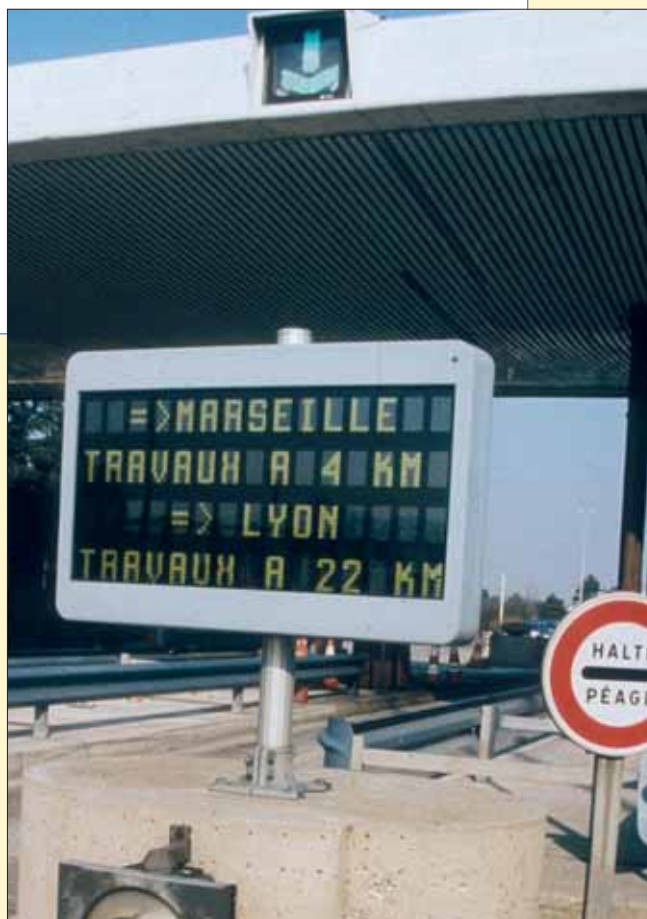
Panneau d'information du trafic autoroutier. Photo : photothèque ASF
