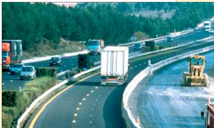
Travaux d'élargissement sur autoroute. Photo : photothèque ASF
