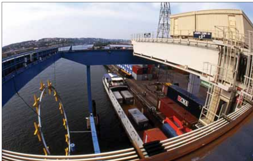
Portique à conteneurs - CNR Copyright : VNF Pascal Lemaître
