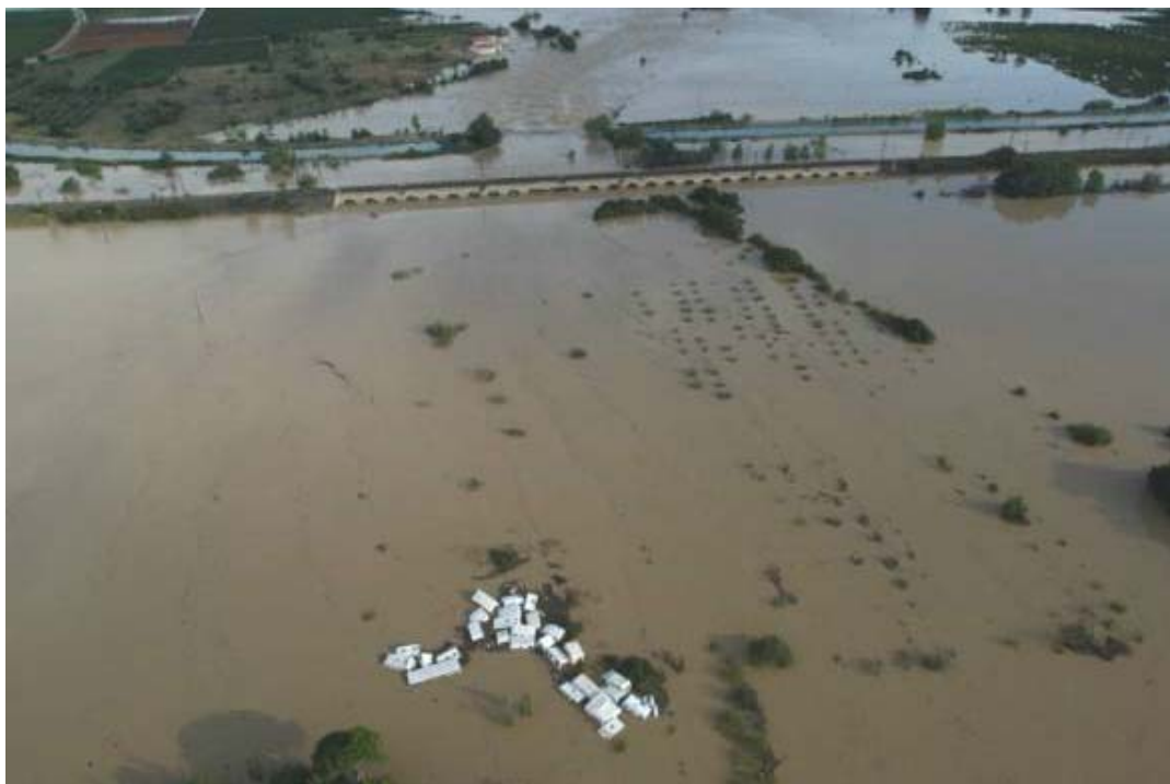
Le "pont aux 28 arches" et le canal BRL au franchissement de la Cubelle. Crédit photographique Dominique QUET "Le Midi libre".
