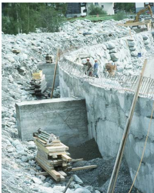
Fig. 7. Renforts garantissant la stabilité des murs à Saas Almagell lors d'une crue extrême
