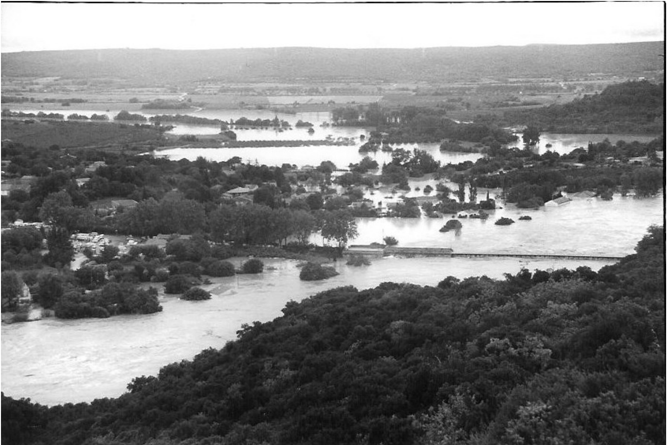
La crue du Gardon à Collias le 9 septembre vers 9h. Au premier plan, le pont. Voir la photo précédente. Au second plan, la Gardonnenque noyée à l'amont des gorges. (voir la partie X du rapport principal).
