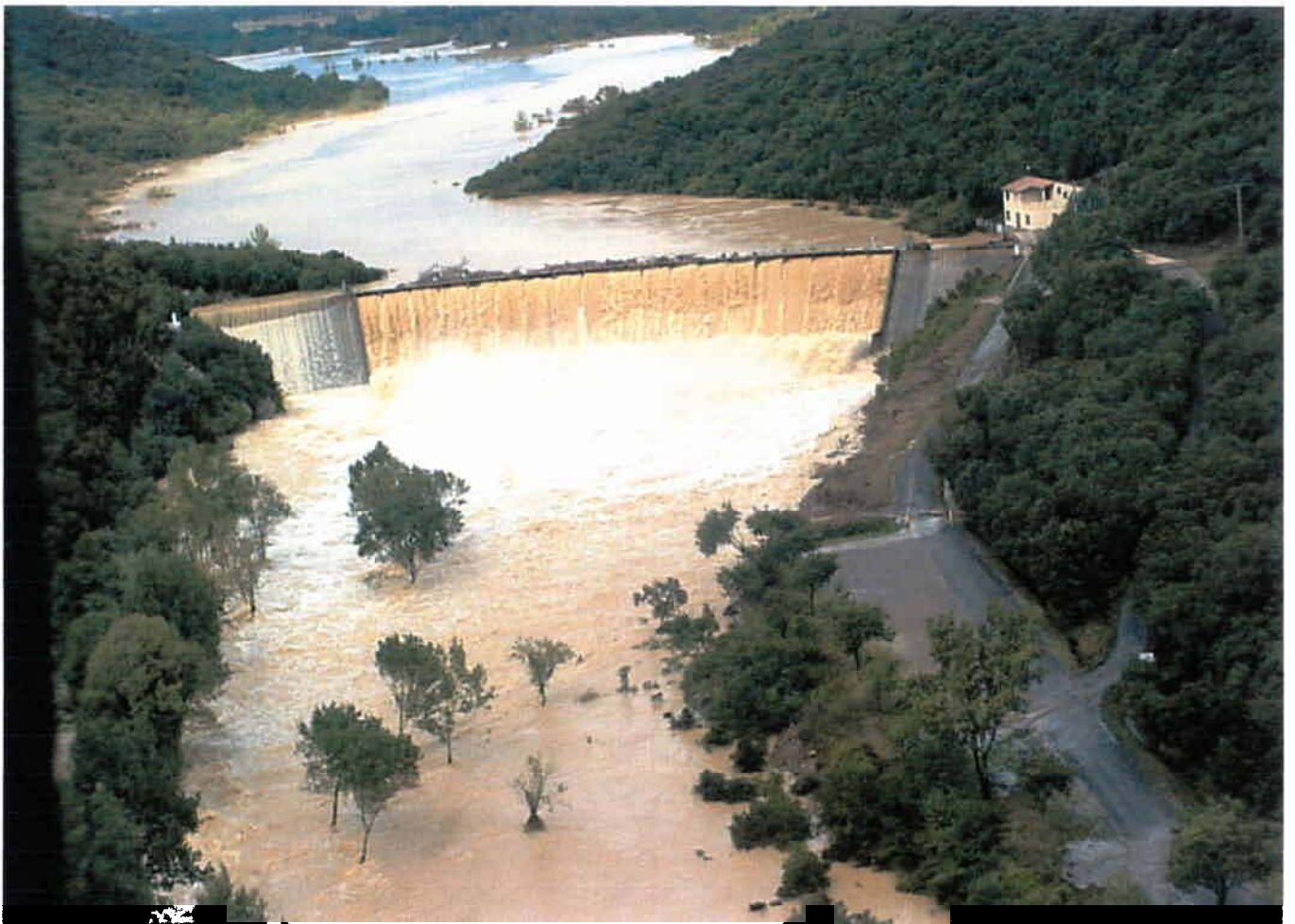
Déversement général sur le parement aval du barrage de la Rouvière, le 9 septembre 2002 (voir la partie IX du rapport principal; le barrage n'est pas construit pour déverser).
