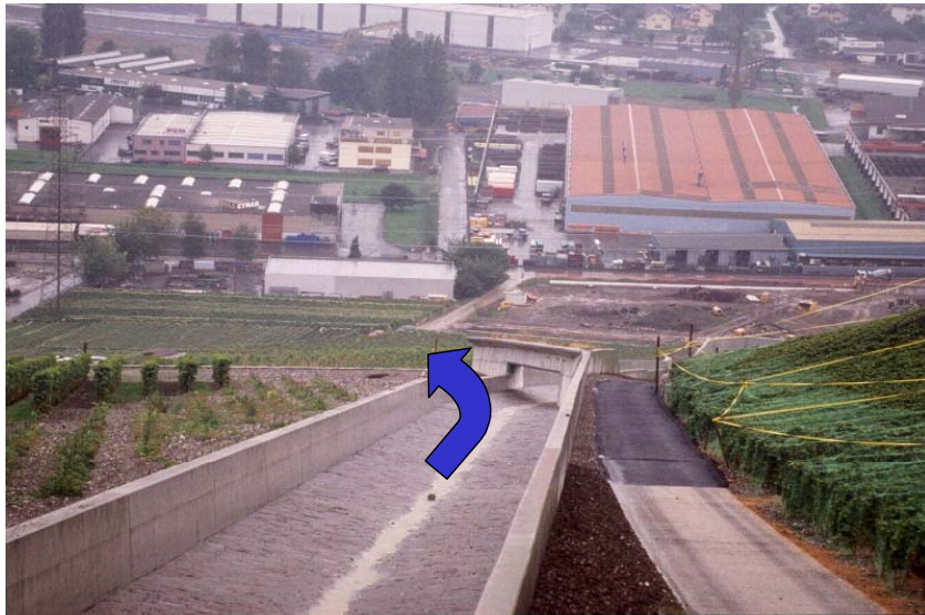
Fig. 8. Déviateur de lave torrentielle sur le Pissot (Villeneuve, VD)
